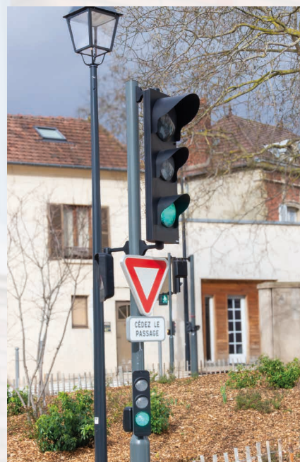
▲ Les carrefours à feux ont également fait l'objet d'une rénovation complète
